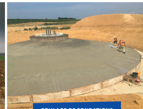
COULAGE DE FONDATIONS
