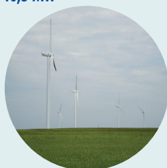
Le parc éolien de Ménil-la-Horgne
