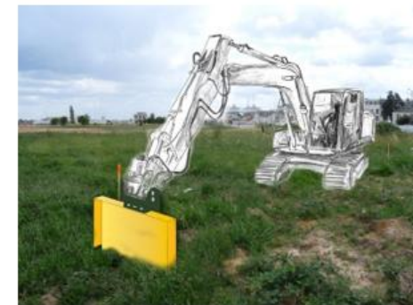
Étape 2 : prélèvement de dalles rectangulaires puis transport sur remorque plateau
